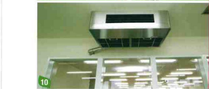
8 洗浄室の全景。2台の洗浄・脱水装置が見える。窓ガラスの向こう側は、次工程である乾燥室だ。右側に見えるシンクは、機械に通せない若葉や紅葉葉など、デリケートな葉を手洗いする際に使用する 9 洗浄・脱水装置と投入作業の様子。投入した葉は、そのまま壁の向こうの乾燥室に運ばれる。一貫ラインになってからは、1オペレーターでこなせるようになり、必要となる手作業も減ったため、「以前と比べて非常に楽になり、作業も速くなりました」(長濱さん)という 10 塩気が高くなる室内環境のため、エアコンや換気扇などの設備も耐塩仕様になっている
