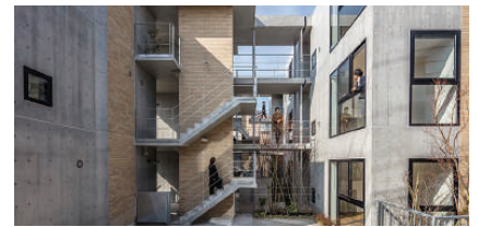
日本基礎技術日吉寮
